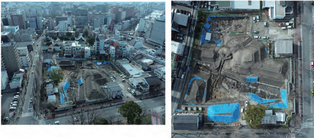
図2 調査区全景写真
